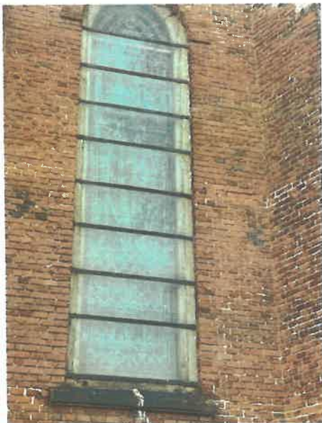
Elewacja kościoła (prezbiterium) od strony wschodniej
