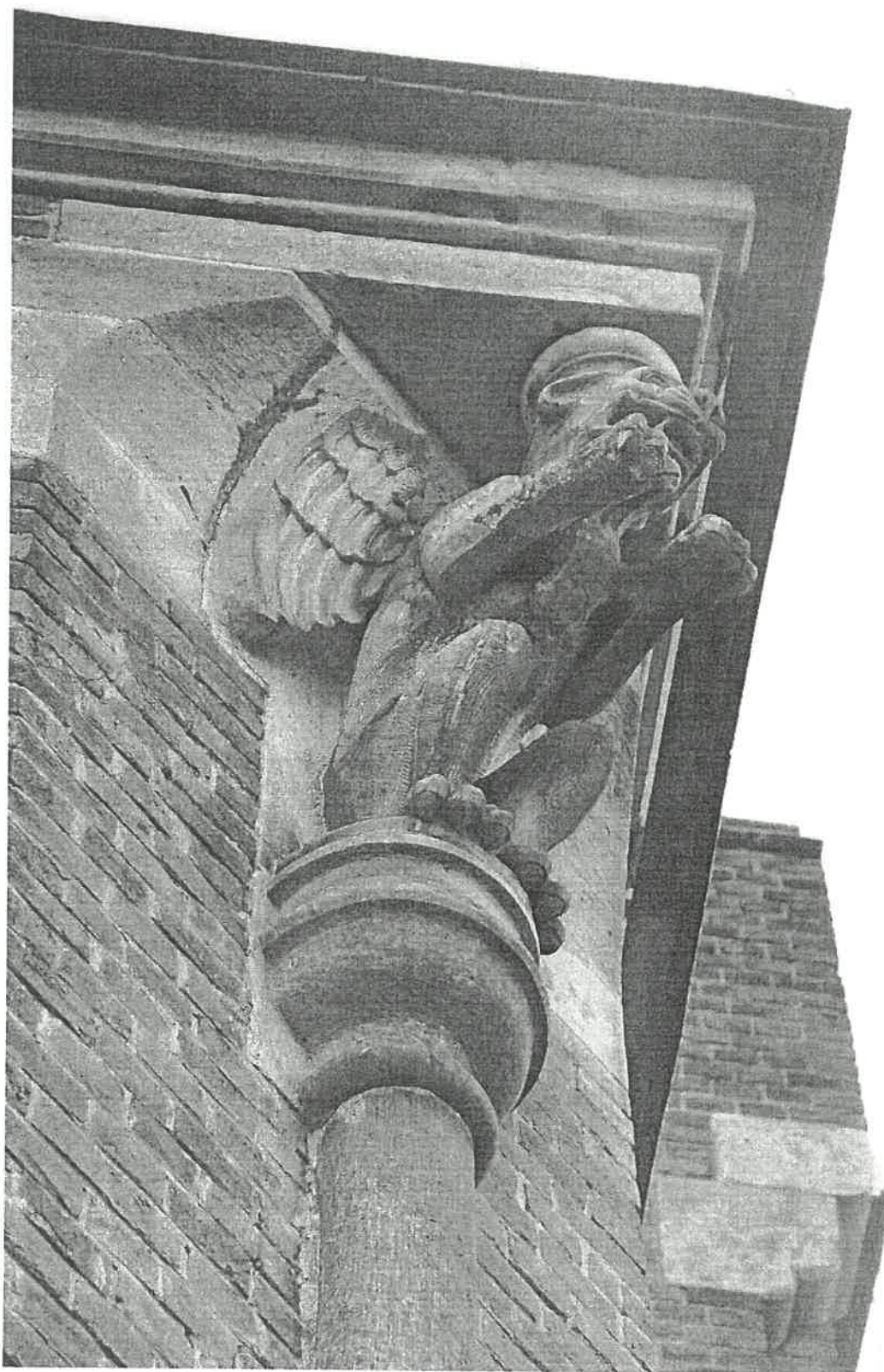
Fot. Nr 30. Kościół parafialny p.w. Św. Mikołaja biskupa w Równem. Stan przed konserwacją.
